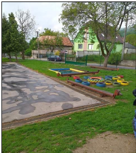
Foto: archív školy. Východiskový stav rekonštruovaného objektu pre deti ŠKD.
